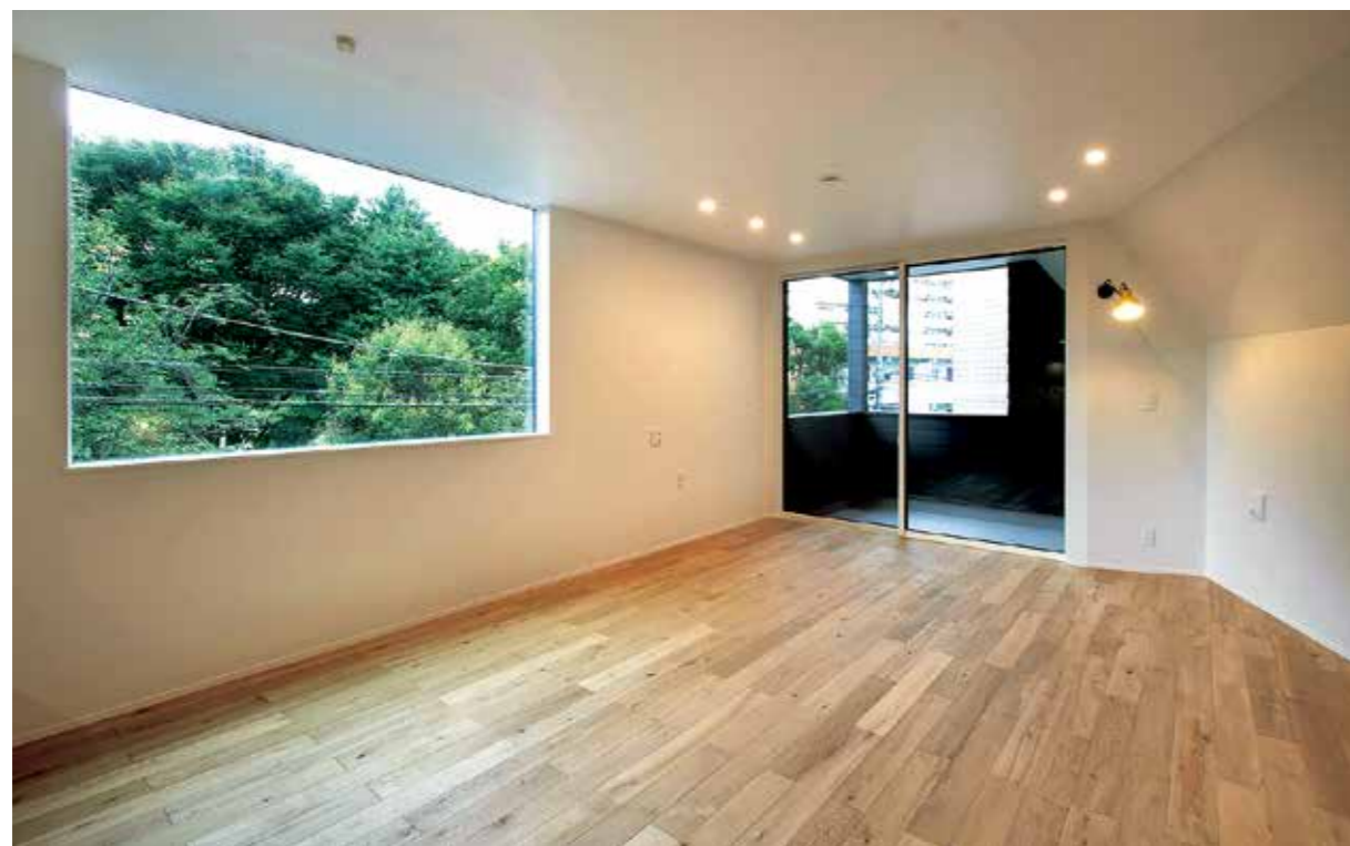
オーク(ナラ) イージーフィット複合(挽板)一枚もの(床暖房兼用) ワイルド【オスモ自然塗装】12×120×909 OKAKS 一級建築士事務所 ARCHIBLAST
