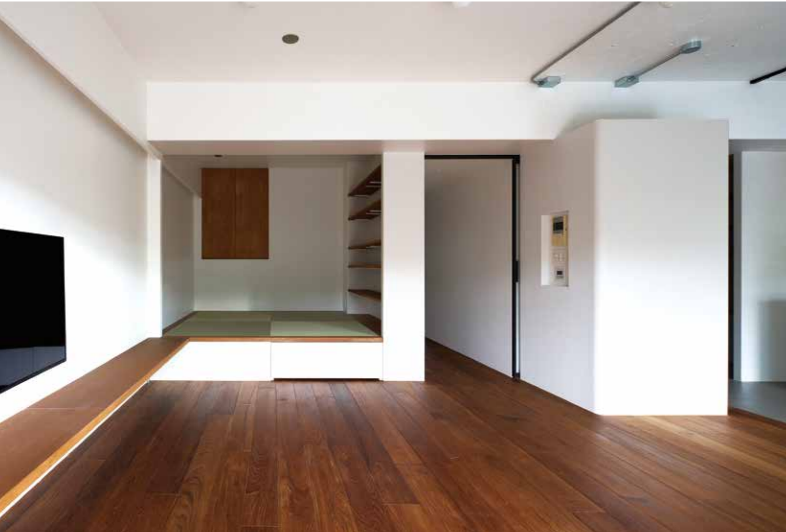
一枚もの(床暖房兼用)ナチュラル【無塗装】15×150×1820 MT20M+リボスアルドボス 向坂建築設計事務所
