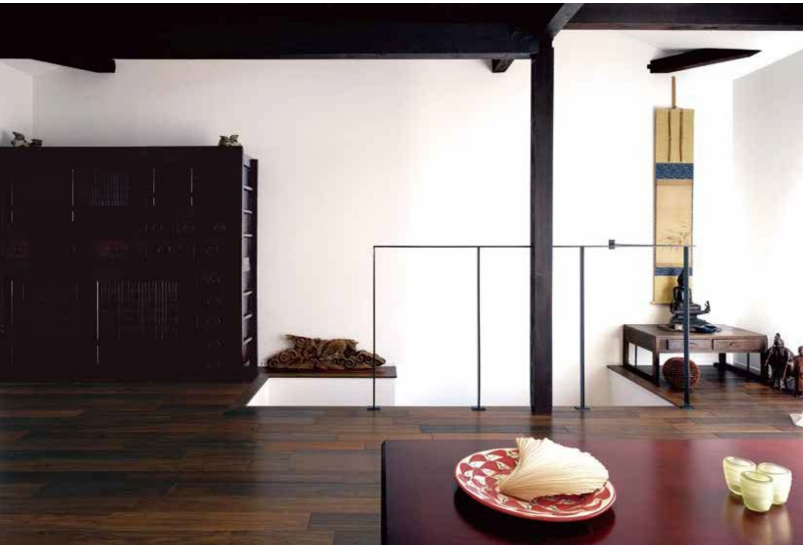
乱尺 ナチュラル【無塗装】15×120×乱尺 AW2RM+現場塗装 (オスモフロアークリアー#3032)
